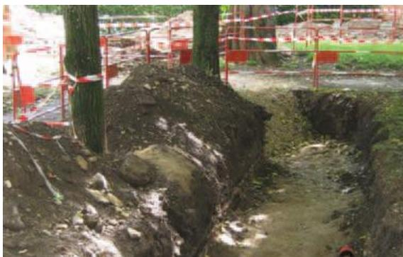
Exemple de dommage : Racines maitresses sectionnées lors d'un chantier
